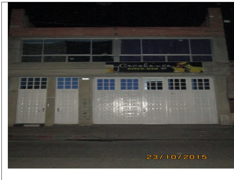
Fotografía No. 2: Avisos del establecimiento COCOBONGO DISCO BAR, No cuenta con Registro de Publicidad Exterior Visual, ubicado en la Carrera 88 A No. 59 C – 34 Sur.
